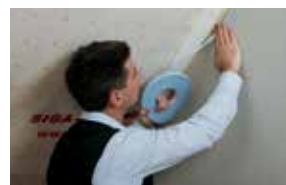
Pare-vapeur sur mur de construction massive Page 30
