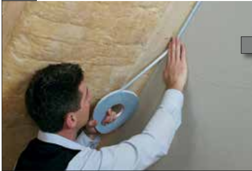
1 Application du cordon avant l'installation du pare-vapeur
