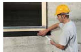
Fenêtre sur mur de construction massive
