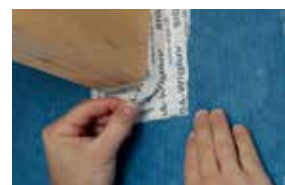
Traversée sur écrans pour façade
