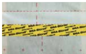
Recouvrements sur un pare-vapeur
