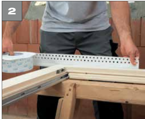
2 • Coller sur le côté du dormant en commençant par le milieu du cadre • Bien appliquer en frottant
