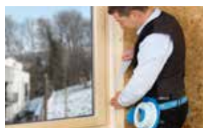
Fenêtre dans un mur à ossature en bois
