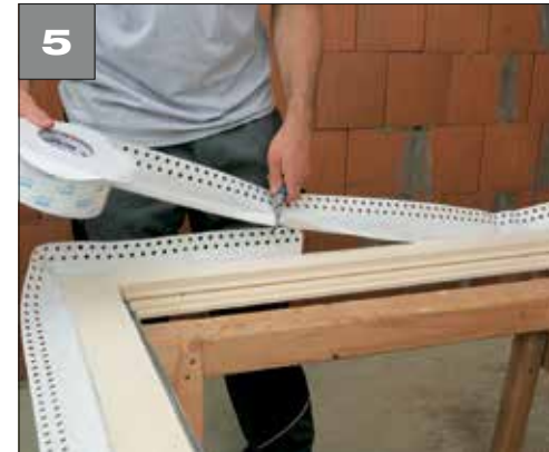
5 Formation des zones de recouvrement : • Laisser déborder de 5 cm environ • Découper
