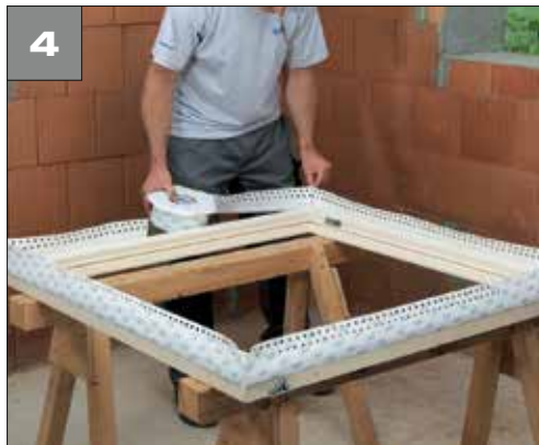
4 • Répéter l'opération sur tous les côtés • Bien appliquer en frottant
