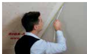
Pare-vapeur sur mur de construction massive
