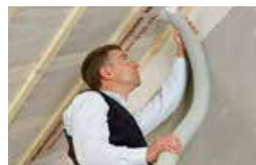
Montage d'un pare-vapeur en cas d'isolation par insufflation Page 73
