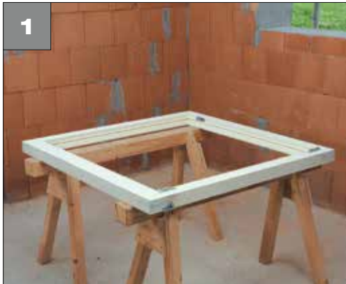
Situation initiale : • Bâti de fenêtre prêt au montage
