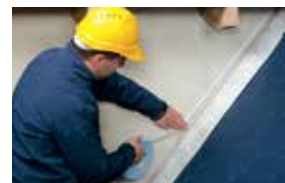
Raccordement d'un écran de sous toiture sur une construction massive
