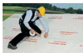
Montage d'un pare-vapeur en cas d'isolation sur chevrons Page 78
