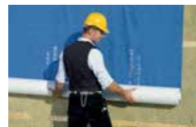
Montage d'écrans pour façade
