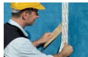
Recouvrement sur écrans pour façades
