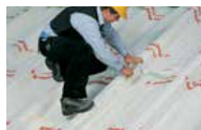
Montage d'un pare-vapeur lors d'un assainissement de toiture par l'extérieur Page 76
