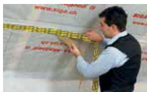
Recouvrements sur un pare-vapeur Page 64
