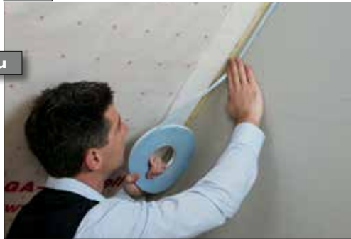
2 Application du cordon après l'installation du pare-vapeur
