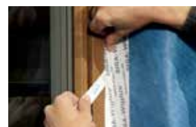
Raccord d'un écran de façade sur une fenêtre
