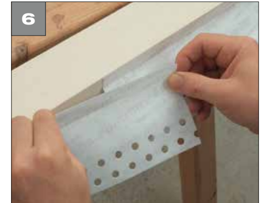
6 Formation des zones de recouvrement : • collage des zones de chevauchement
