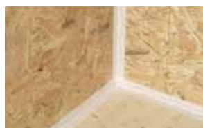
Raccordement de murs dans la construction en bois
