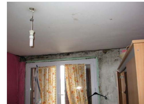
■ Moisissure due à une mauvaise ventilation
